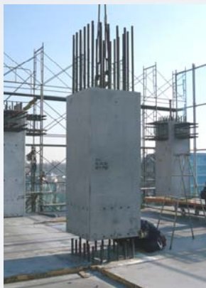
PRECAST METHOD(COLUMN)
