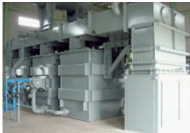
70t電気炉受電用変圧器
