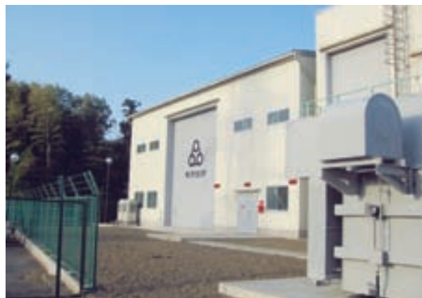
70t電気炉受電用変圧器収納建屋
