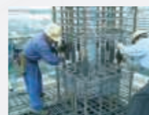
ネジテツコン施工例
