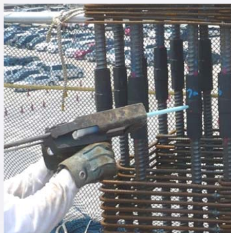
注入 TTK 樹脂填充材
