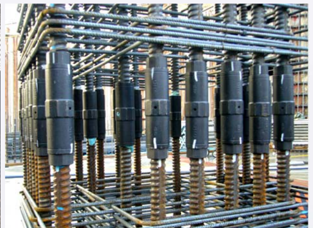
中央鋼筋使用 EPOCH JOINT
