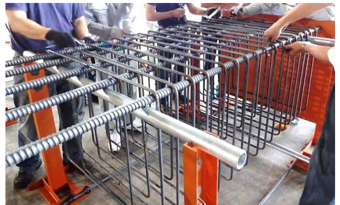
配筋狀況 (工廠鋼筋預組工法)
