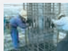
ネジテツコン施工例
