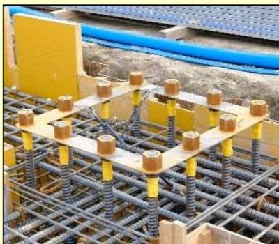
型枠設置後の芯位置確認及び固定
